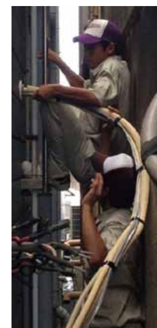
地元の電気工事会社の指導で、空調の取り付けを実習
